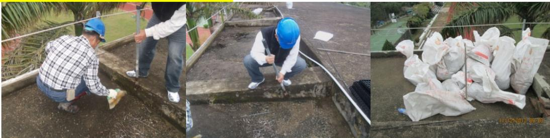
(二) 排水孔部份先行清除並以水泥砂漿修補。
